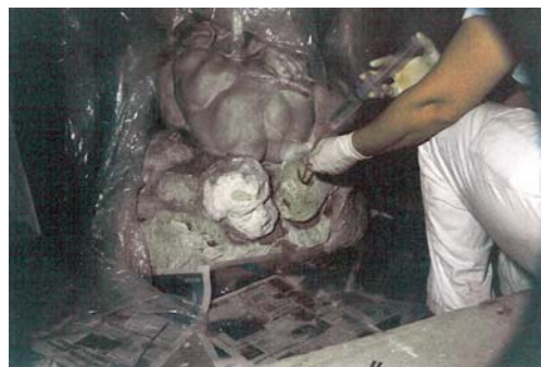
Figura 5 Particolare cuscino di nuvole statua della Madonna col Bambino (XVII sec.). Consolidamento stucco tramite infiltrazioni di malta di calce fluida. Foto intervento.
