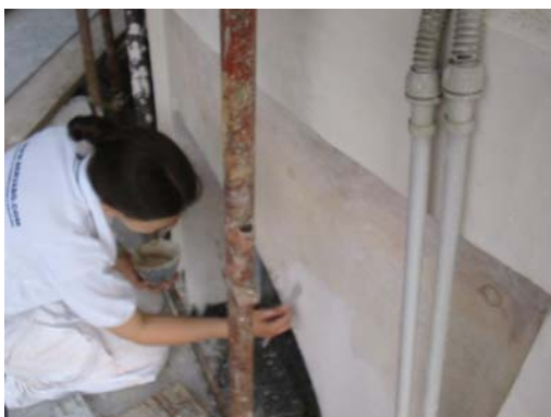
Figura 10 Particolare tamburo in marmorino della cappella della Madonna del Carmine a inizio restauro.
