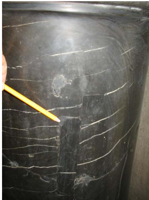
Figura 4 Particolare cappella della Madonna del Carmine in fase di restauro. La rimozione della vernice nera ha riportato in luce le venature bianche del Baveno nero. Sono inoltre emerse segni di tasselli di inserto.
