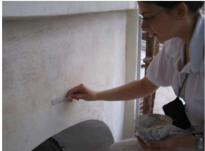
Figura 9 Particolare tamburo in marmorino della cappella della Madonna del Carmine dopo la pulitura ed in fase di stuccatura delle fessurazioni.
