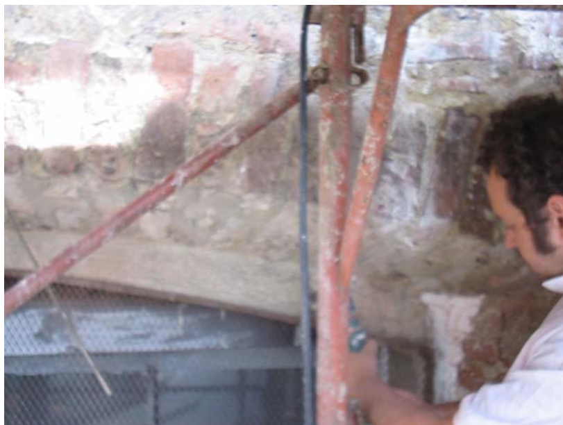
Figura 12 Particolare del consolidamento degli abbassanti archi finestre abside con resina con inserimento di barre in inox e vtr.
