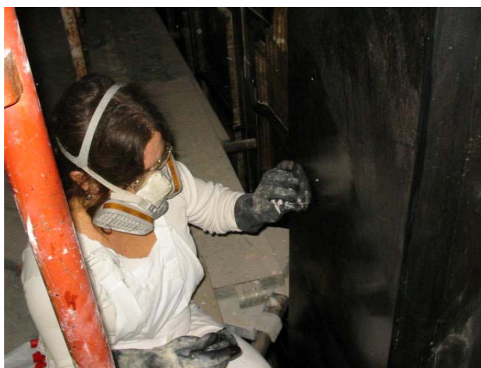
Figura 3 Particolare cappella della Madonna del Carmine in fase di restauro. Rimozione vernice nera.
