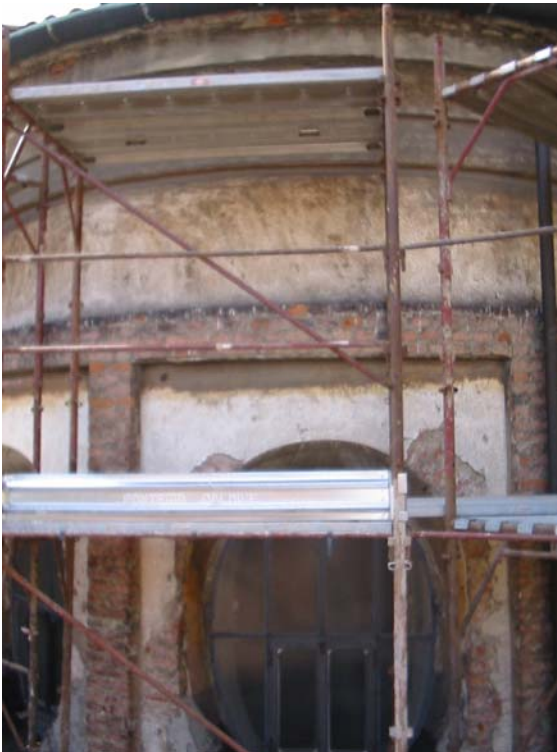
Figura 8 Particolare timpano in marmorino della cappella della Madonna del Carmine a inizio restauro.
