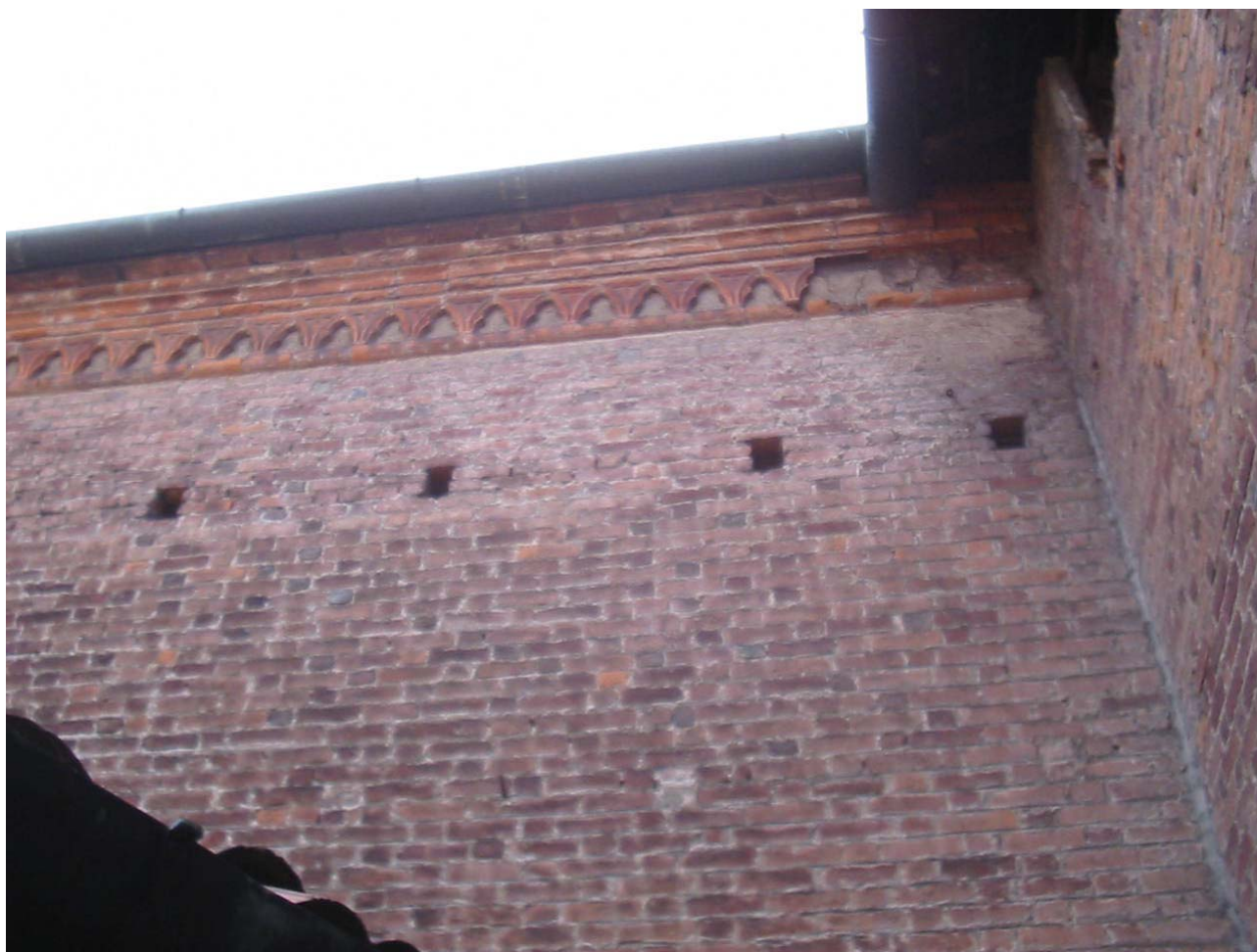
Figura 13 Superficie esterna abside a intervento ultimato.
