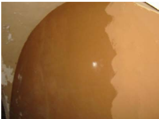
Figura 4 Inizio della fase di rimozione intonaco marrone e messa in luce affresco della seconda lunetta.
