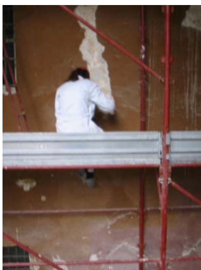
Figura 1 Inizio della fase di rimozione intonaco marrone e messa in luce affresco della quarta lunetta.
