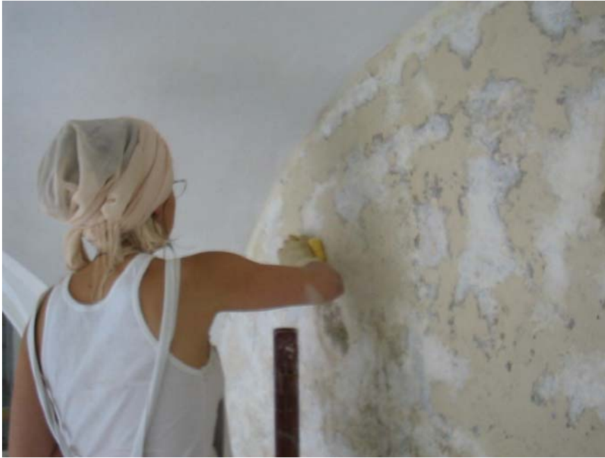
Figura 7 Ottava lunetta in fase di chiusura delle lacune con malta di calce e polvere di marmo analoga a quella antica.
