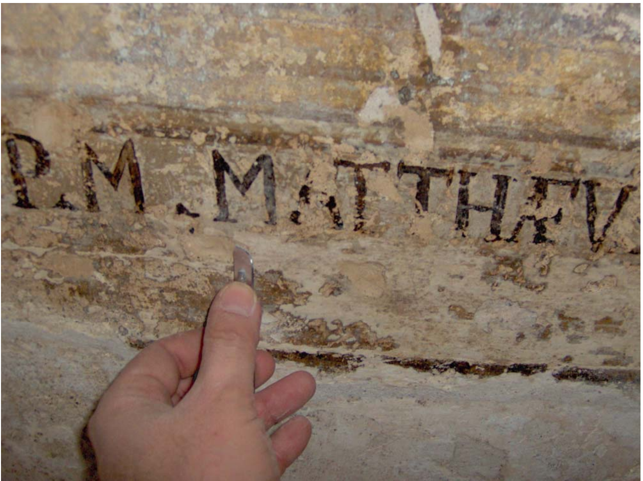
Figura 8 Particolare affresco quarta lunetta in fase di disialbo. L'intervento ha riportato in luce questa fascia alla base delle lunette con forse il nome o epitaffio dell'uomo illustre rappresentato.
